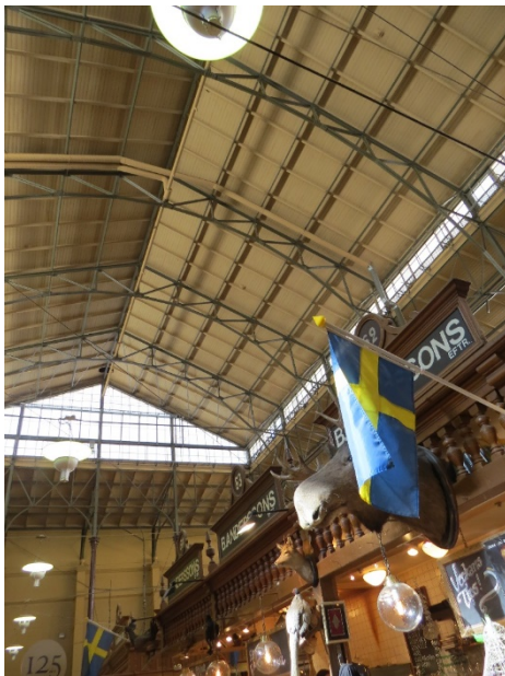
Bild 1 Tidiga stålkonstruktioner i Östermalms Saluhall, Stockholm.
