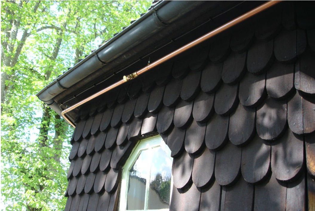
Bild 6: Ett exempel på ett sprinklersystem med öppna sprinkler installerade för att vattenbegjuta en ytterfasad på en av Sveriges äldsta träkyrkor. Sprinklersystemet aktiveras sektionsvis och automatiskt via en signal från den värmedetektionskabel som är installerad under takfoten. Här kan även noteras att sprinklerrören är tillverkade av koppar. I utomhusmiljö sker en oxidation av koppar, varvid det med tiden bildas ett mörkbrunt skikt på metallens yta som gör röret mindre synligt. Foto: Magnus Arvidson, RISE.
