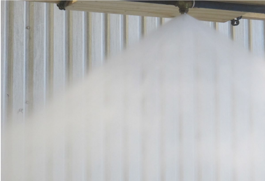
Bild 4: Exempel på vattensprayen från ett munstycke för "vattendimma" vid omkring 15 bars vattentryck. Foto: Mourhaf Jandali, RISE.
