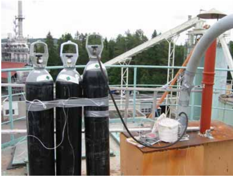
Figur 18 Vid försök 5 matades koldioxid in i silotoppen från tre flaskor försedda med stigrör.
