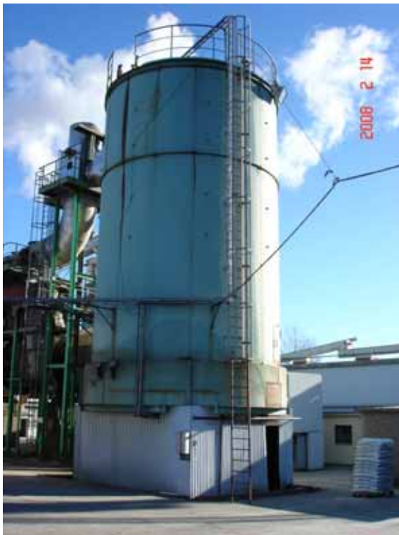
Figur 13 Försökssilon var 6 m i diameter (6,4 m närmast silobotten) , 10,5 m hög och placerad på ett stålstativ ca 2,5 m ovan mark.
