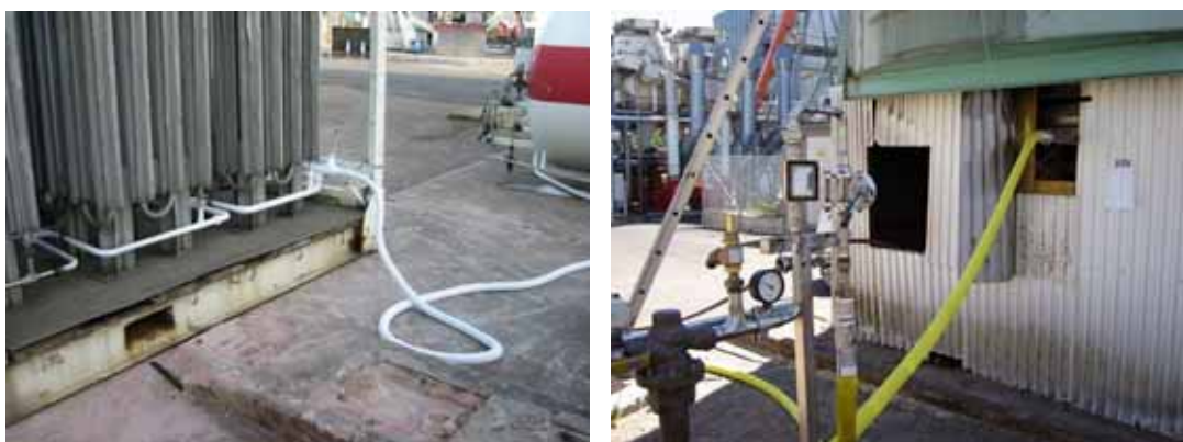
Figur 17 Gasutrustning som användes vid försöken bestod av a) en kryptank med 5,5 ton flytande kvävgas kopplad med en metallslang till en luftförångare. Efter förångaren placerades b) en mät- och reglerstation för tryck och flöde innan gasen leddes in i silon via en flatrullad slang.
