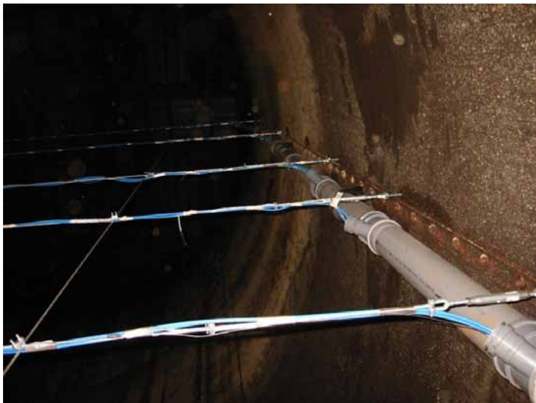
Figur 15 Foto som visar det vadersystem som användes för att positionera samlings-slangarna och termoelement. Dessa leddes igenom en tätningmuff till ett vertikalt samlingsrör och ner till gassamlingsutrustningen belägen under silon.
