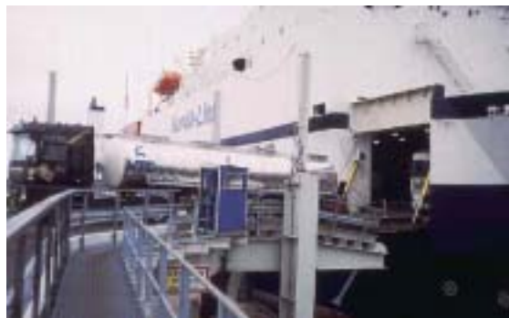
Vattenbaserade släcksystem kan, med vissa överväganden, användas för de flesta typer av lastrum och ro-ro däck ombord på fartyg. 2003-04-29
