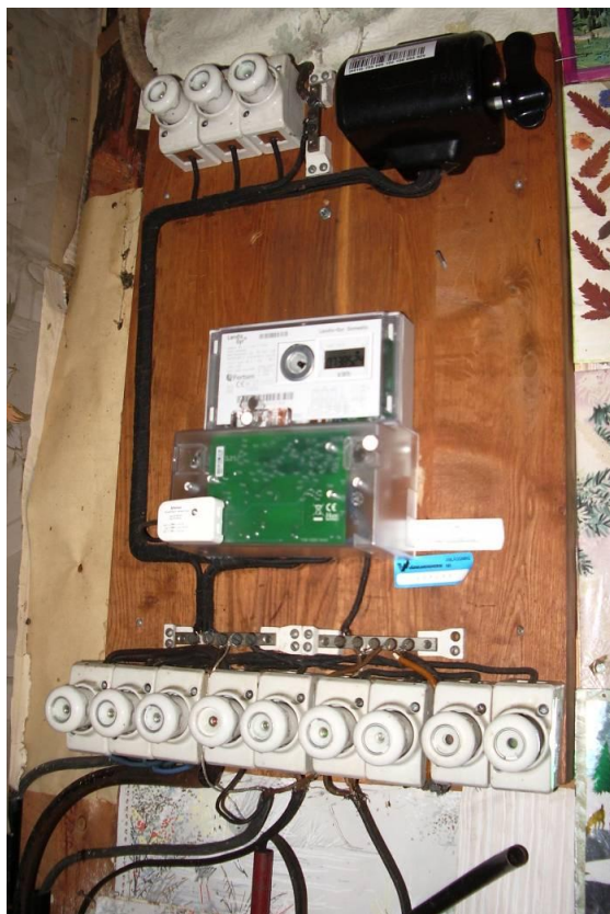
Figur 4: Huvudcentral med elmätare.
